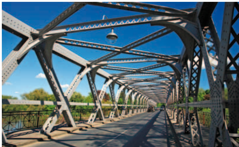
Stalowy most nad Odrą w Brzegu
