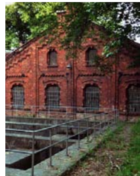
Oczyszczalnia ścieków w Opolu
